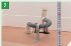
給水管の干渉を避けられるフレキホースを既設の排水管に取り付け、勾配をつける。
