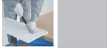
測定した高さに合わせてパネル裏のガイド部分を切断し、取り付けるだけのカンタン作業。
